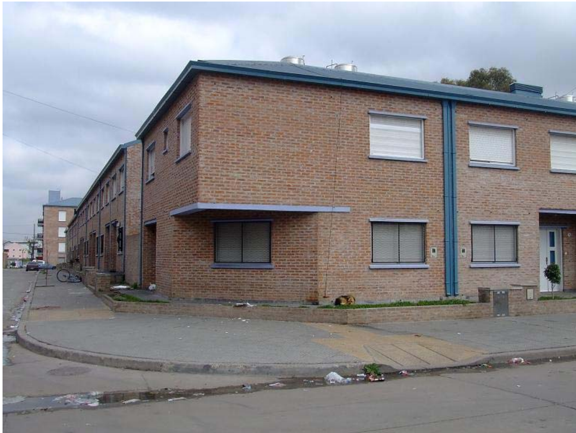
NHT – ZAVALETA – Barrio de Barracas. Detalle de esquina del bloque de viviendas INDIVIDUALES.
