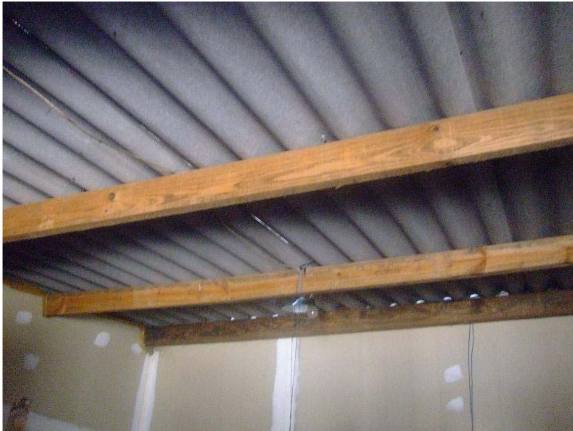
Vista del interior de una de las viviendas, sin cielorraso.
