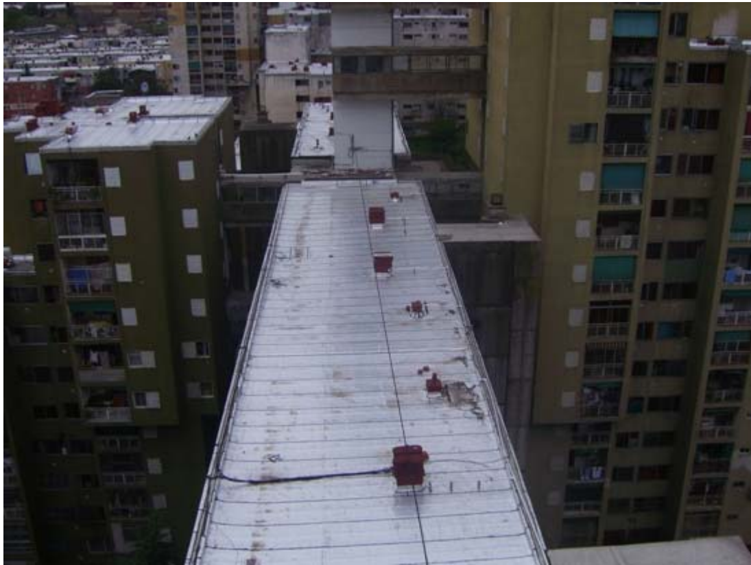
Reparación e impermeabilización realizada sobre techos.
