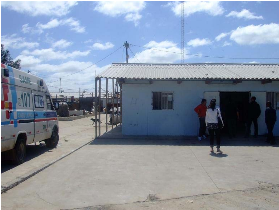
Vista exterior de la sala de Primeros Auxilios.
