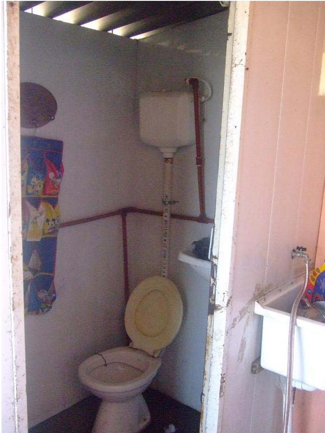
Vista de los baños que poseen las viviendas individuales.
