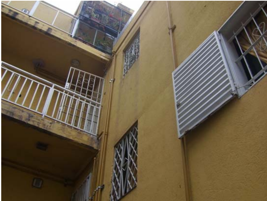
Subida de cañerías de gas en Barrio Soldati
