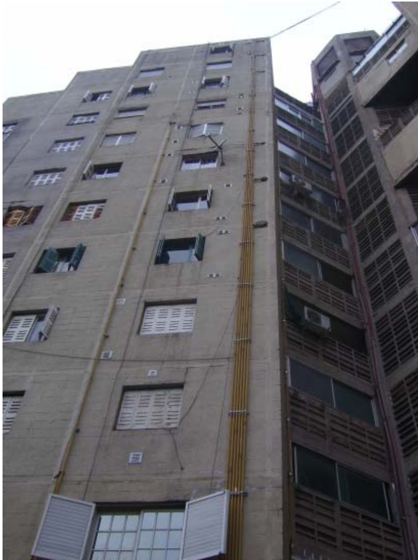
Reemplazo de cañerías de Gas, instalación externa.
