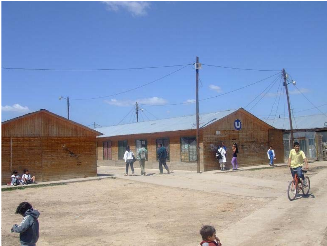
Vista de las ultimas tiras con el sistema de "emplacado de madera machimbrada".
