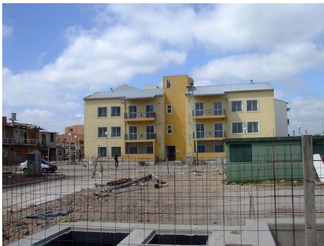
Ex VILLA 3 – Mz 109 K y J – Vista desde la cámara de tratamiento de agua.
