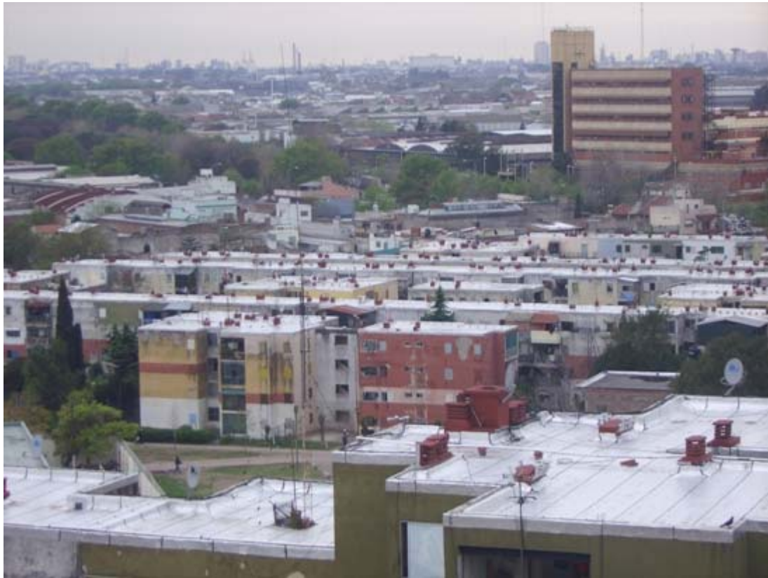
Vista de otro sector del barrio. Algunas terminaciones deficientes en cañerías de agua en terrazas por falta de soportes.
